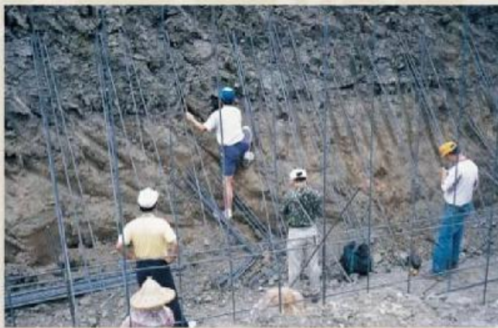
大城國小新舊土埆施工工程開挖之處，明顯有黑、黃二層泥岩，泥岩之後隙帶即舊土埆破壞處。
